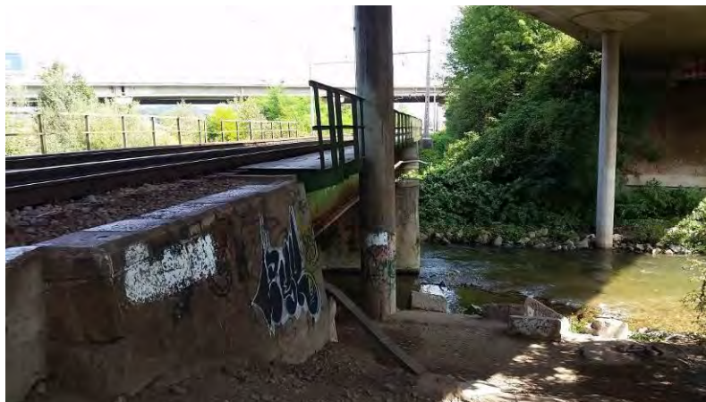
Levo most Mali Graben, desno cestni nadvoz nad njim; viden podporni steber nadvoza, ki praktično sega v spodaj ležeči most
