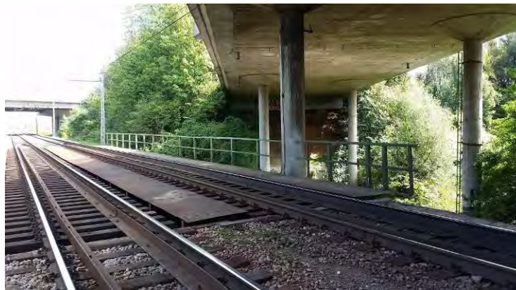
Levo viden zgornji ustroj na obstoječem mostu Mali Graben, desno obstoječi cestni nadvoz nad mostom
